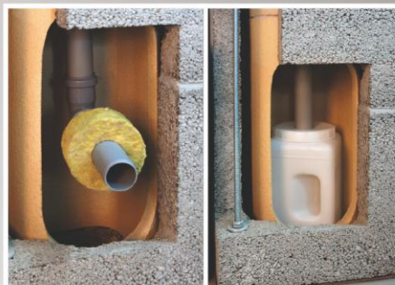
2 Можливі способи відведення конденсату: до каналізації або до ємності для збору конденсату
