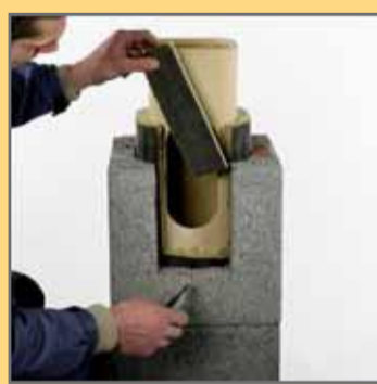
4. Підрізати плиту з мінерального волокна до розмірів отвору в пустотілому блоці.
