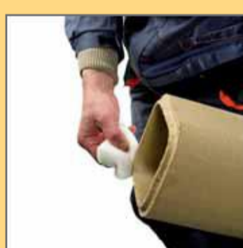
10. Очистити шпунтове з'єднання вологою губкою.
