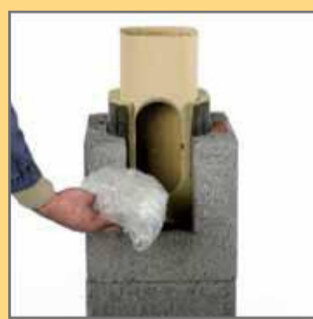
5. Всередину очисного люка покласти фольгу або листок паперу для захисту від падаючого розчину.
