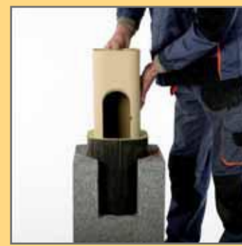
3. Встановити перший керамічний елемент - очисний люк.
