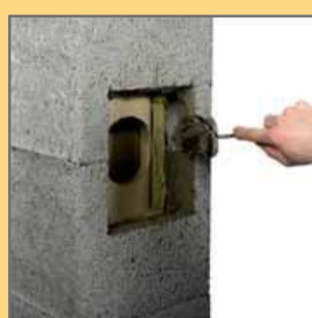
17. На стінки підготованого отвору накласти розчин.
