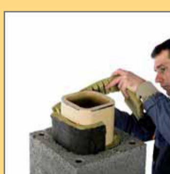
19. Відрізати надмір волокна за останнім пустотілим блоком.
