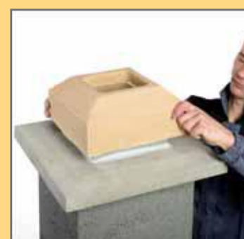
30. Приклеїти керамічну обшивку гирла димоходу.
