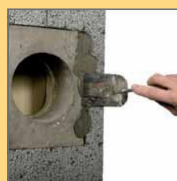
18. ... і поставити на нього бетонний приєднувальний елемент.
