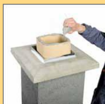
29. Накласти замазку на підрізану керамічну трубу.
