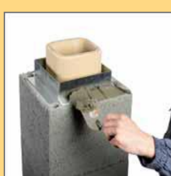
25. Встановити незнімну опалубку, накласти будівельний розчин.
