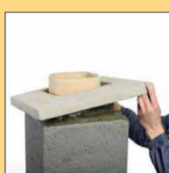
26. Встановити на розчин бетонну накривну плиту.
