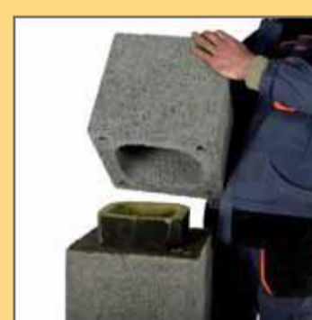
9. Розмістити на розчині наступний пустотілий блок.
