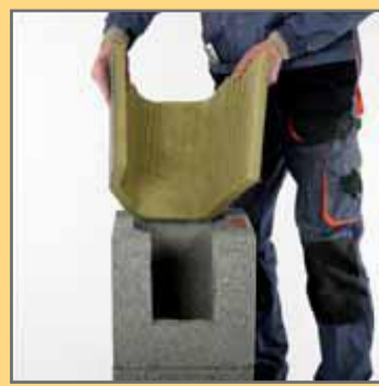
2. Поставити пустотілий блок з вирізаним отвором на дверцята (16x31 см) на цокол, встановити плиту з мінерального волокна.
