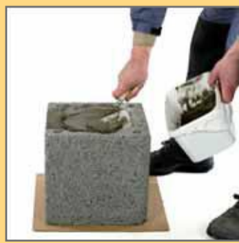
1. На шарі ізоляції (наприклад, будівельна фольга, бітум) встановити пустотілий блок і заповнити його розчином на відповідну висоту, формуючи цоколь. Вирівняти.
