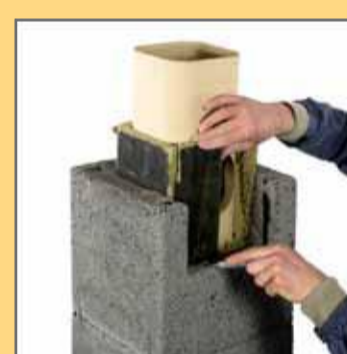
15. Підрізати волокно до підготованого отвору.
