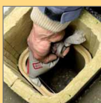
11. Накласти кислотостійку замазку.
