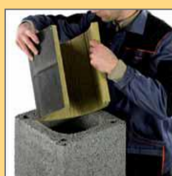
8. Вкласти мінеральне волокно до наступного пустотілого блоку.
