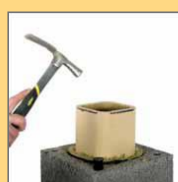
21. Вбити монтажні кілочки в наріжні отвори пустотілого блока.
