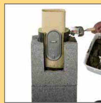
6. Накласти будівельний розчин на пустотілий блок.
