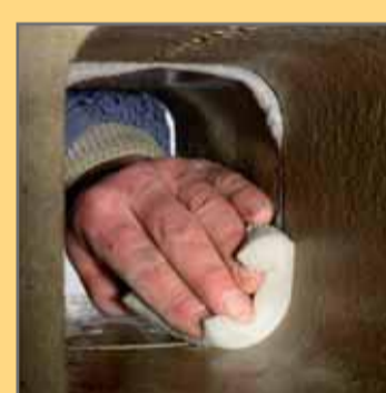
12. Усунути надмір замазки з внутрішньої сторони шва за допомогою вологої губки.
