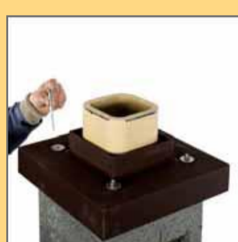
23. Закрутити гвинти, накласти гумові і металеві шайби, прикрутити ковпачковими гайками.
