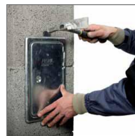
Зовнішні дверцята прочистки кріплять за допомогою цвяхів (покрівельних цвяхів).
