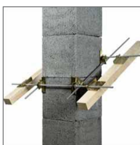
Закріплення димоходу в місці проходу через дах.
